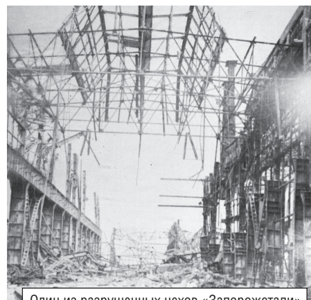
Один из разрушенных цехов «Запорожстали»
